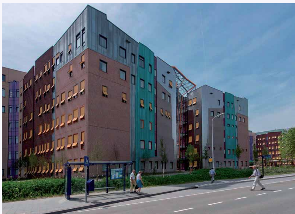
FIGURA 14. Veduta dell'esterno di un blocco a farfalla. (Foto tratta dal sito www.isalavirtueletour.nl )
