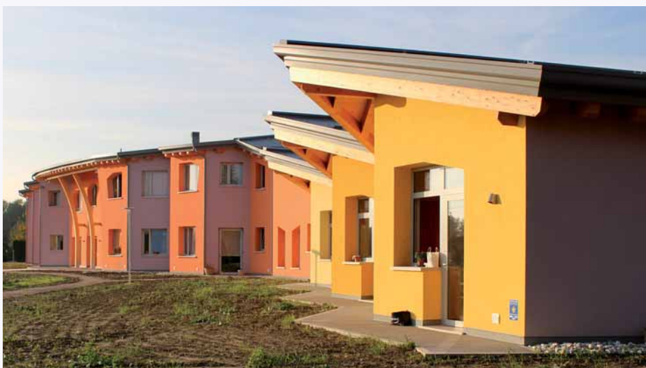
FIGURA 1. Scorcio da sud-est del fronte Sud.
