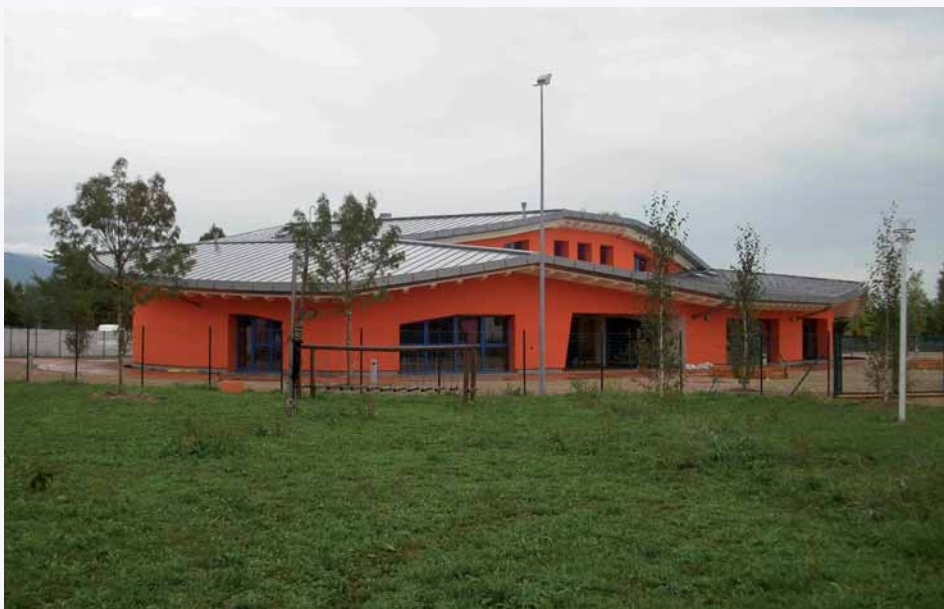
FIGURA 1. Prospetto Sud - Ovest.
