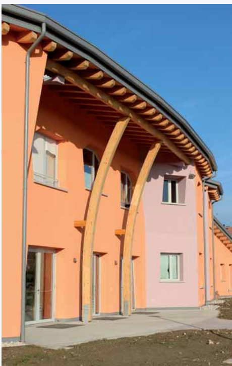
FIGURA 6. Particolare fronte ingresso Sud.
