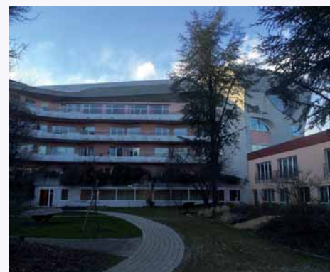
FIGURA 5. Vista delle balconate delle camere.
