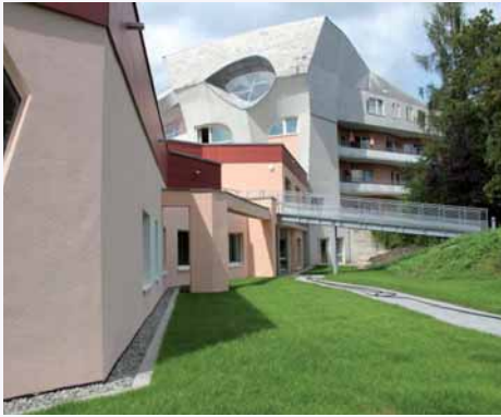
FIGURA 9. Vista della grande finestra che illumina lo spazio per le feste, detta "l'occhio di Dio".
