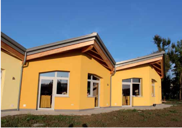
FIGURA 7. Ala Asilo: particolare fronte Nord.
