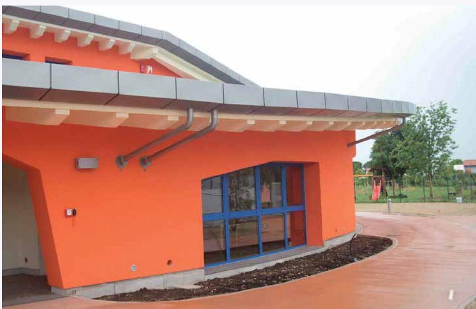
FIGURA 4. Prospetto Sud - Ovest.
